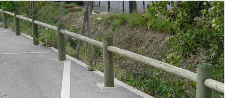
Fig 60 : Un système de contention résistant pour le cloisonnement entre les flux «doux» (piétons et cycles) et les flux automobiles lorsque les disponibilités foncières ne permettent pas de créer des lisières
