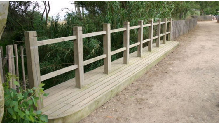
Fig 62 : Exemple de garde-corps simple en bois
