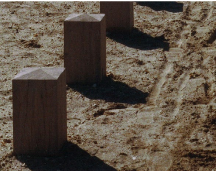
Fig 63 : Exemple de bornes en bois pour assurer la contention des véhicules
