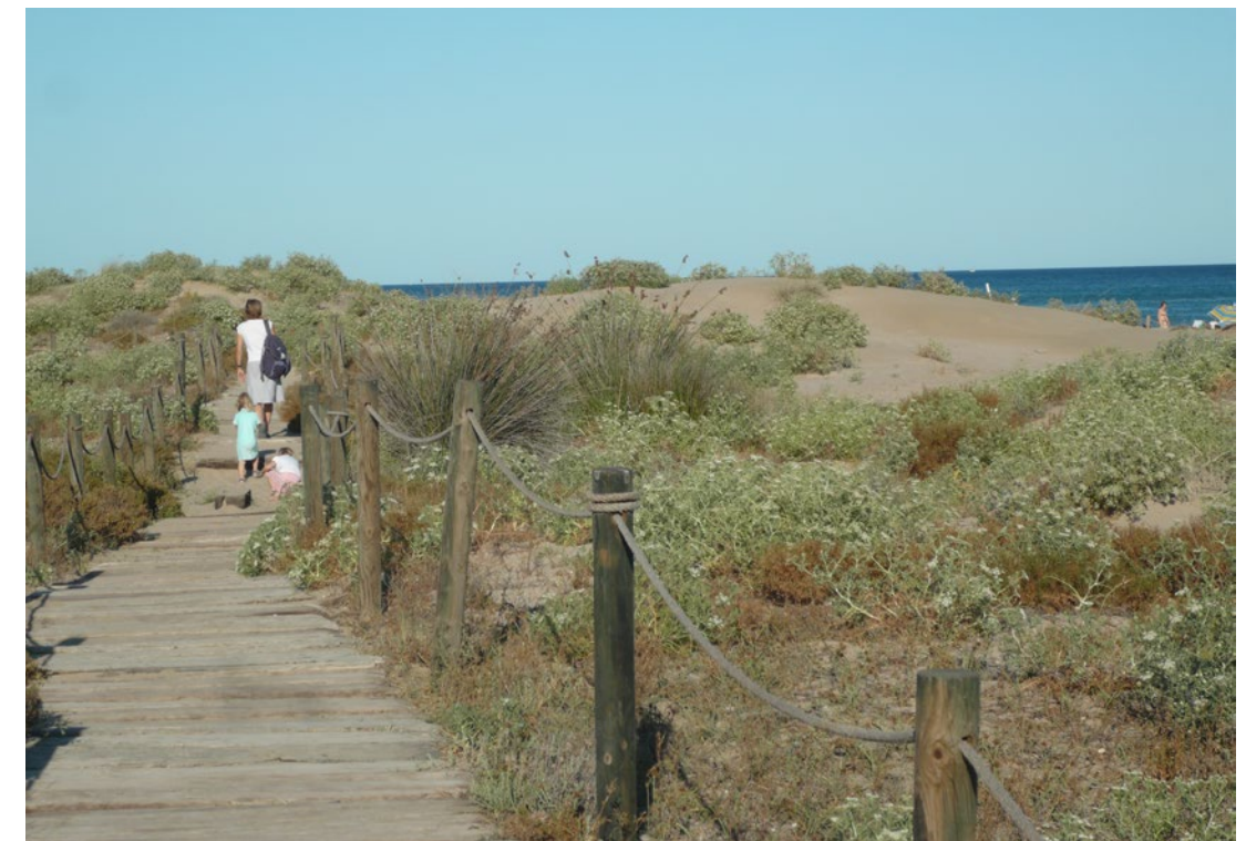
Fig 55 : Des traverses de bois posées à même le sol : un mariage garanti avec la végétation de la dune
