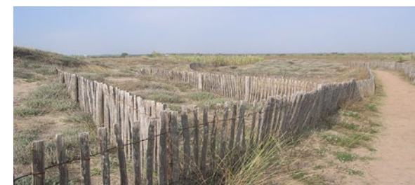
Fig 64 : L'entretien des ganivelles : remplacement des sections dégradées, redressement des sections couchées, remise en tension...
