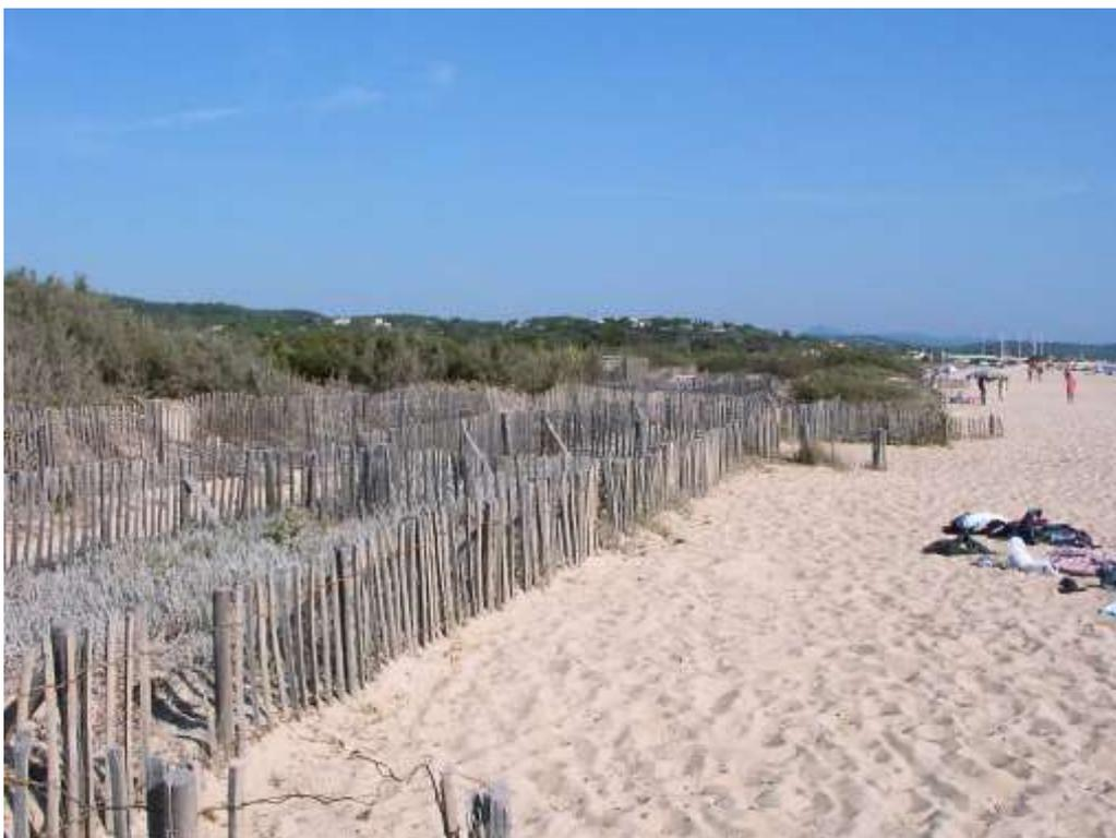
Ouvrage de réhabilitation du cordon dunaire ; noter le manque d'entretien de l'ouvrage, et le développement du diotis entre les lignes
