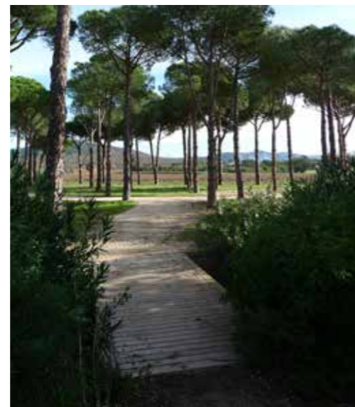
Fig 53 : Sol au niveau d'un franchissement : platelage bois
