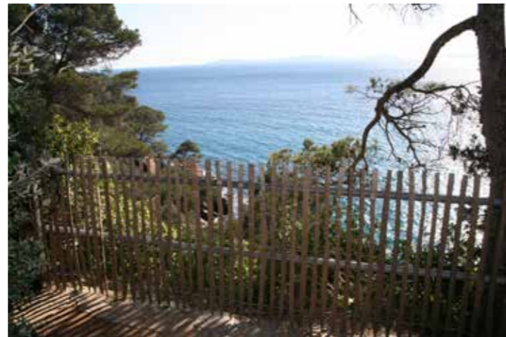
Fig 59 : Un garde-corps dérivé des ganivelles : intégration aux paysages littoraux (référence à la dune) et transparence (continuités paysagères)
