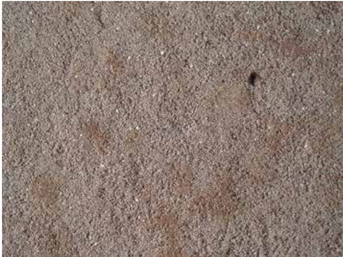
Fig 52 : Stabilisé : des déplacements confortables, notamment pour les itinéraires PMR
