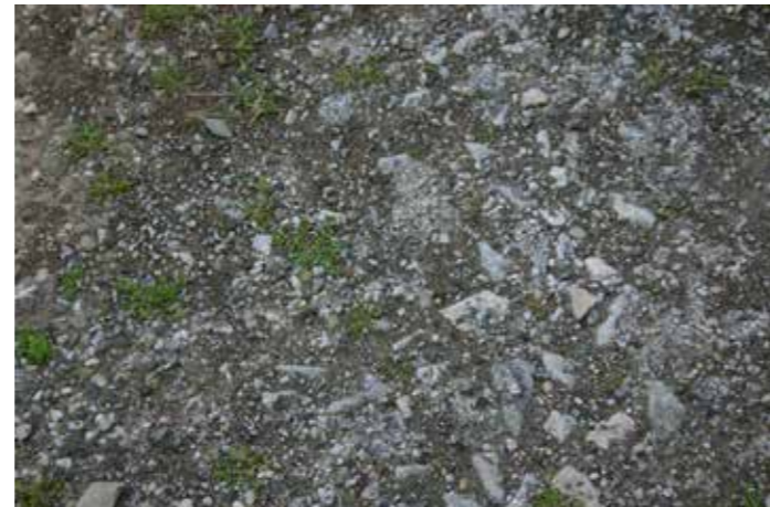
Fig 51 : Mélange terre - pierre compacté : un sol renforcé d'aspect naturel
