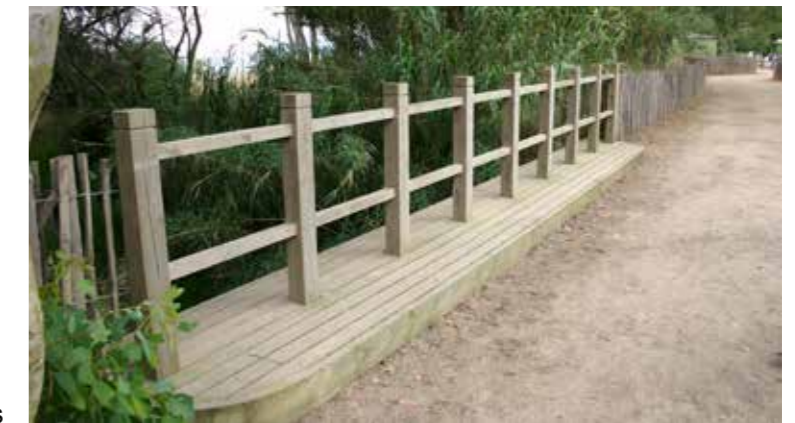
Fig 62 : Exemple de garde-corps simple en bois
