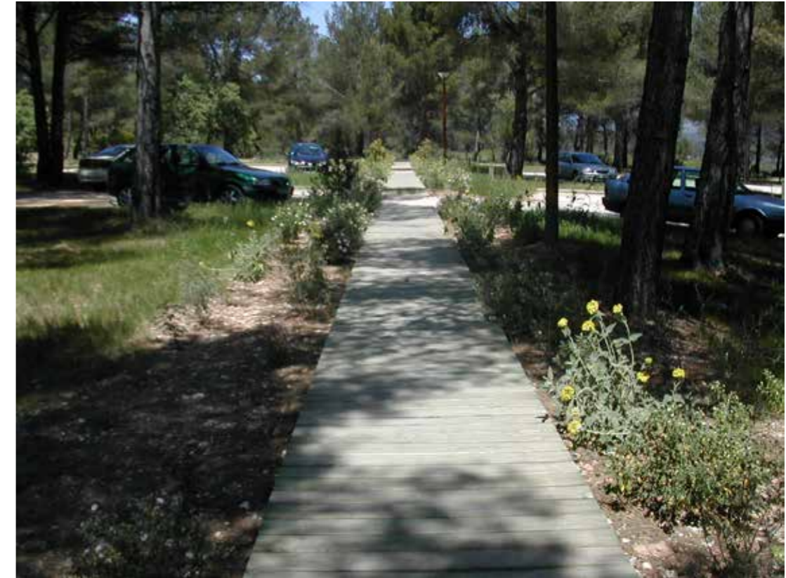
Fig 54 : Un platelage bois pour un sentier drainant les flux piétons d'une aire de stationnement (une surface praticable par les personnes à mobilité réduite)
