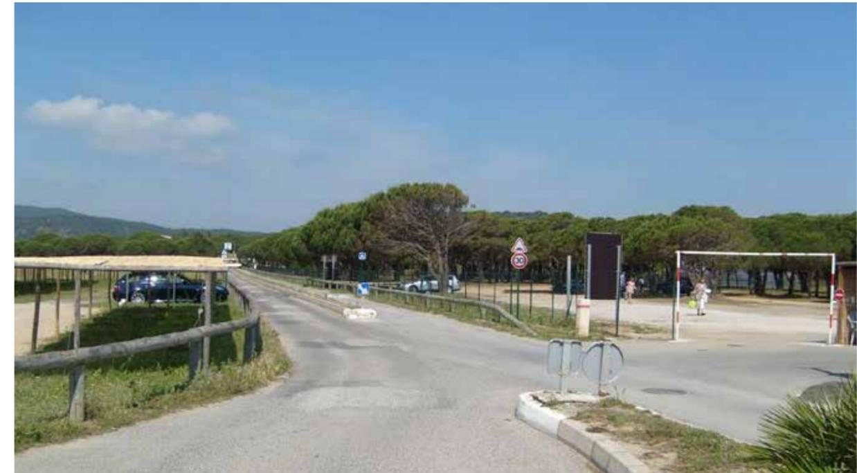
Fig 70 : La route de l'Epi : un système de protection des piétons et de limitation du stationnement sauvage en rondins de bois. Cette voie dessert deux aires de stationnement privées.
