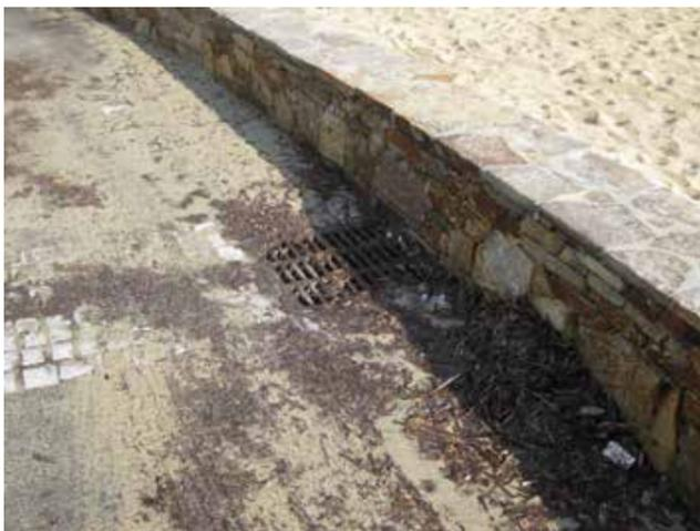
Fig 113 : Grille d'évacuation des eaux pluviales en aval du boulevard Patch – colmatage complet de l'ouvrage
