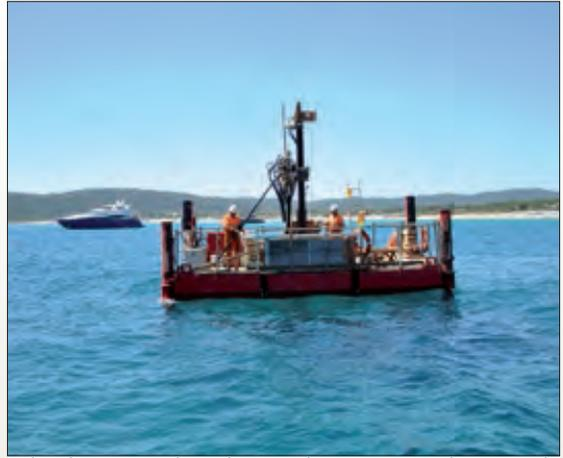
Plateforme pour la réalisation des carottages du sous-sol
