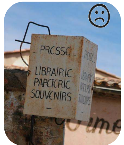
Une enseigne peu entretenue, Place de l'Ormeau
