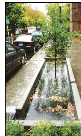
Réservoir paysagé rempli d'eau après une forte pluie
