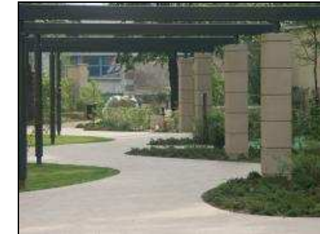
Revêtement de sol poreux
