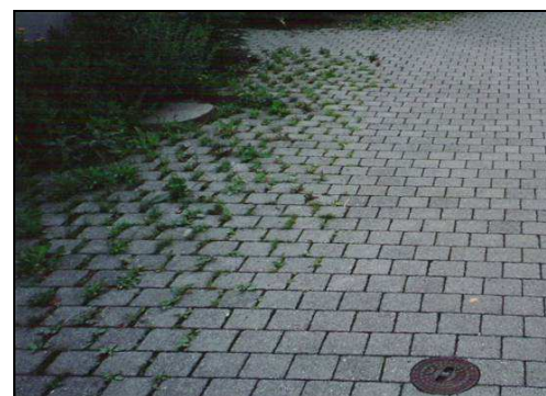
Espacement progressif des pavés
