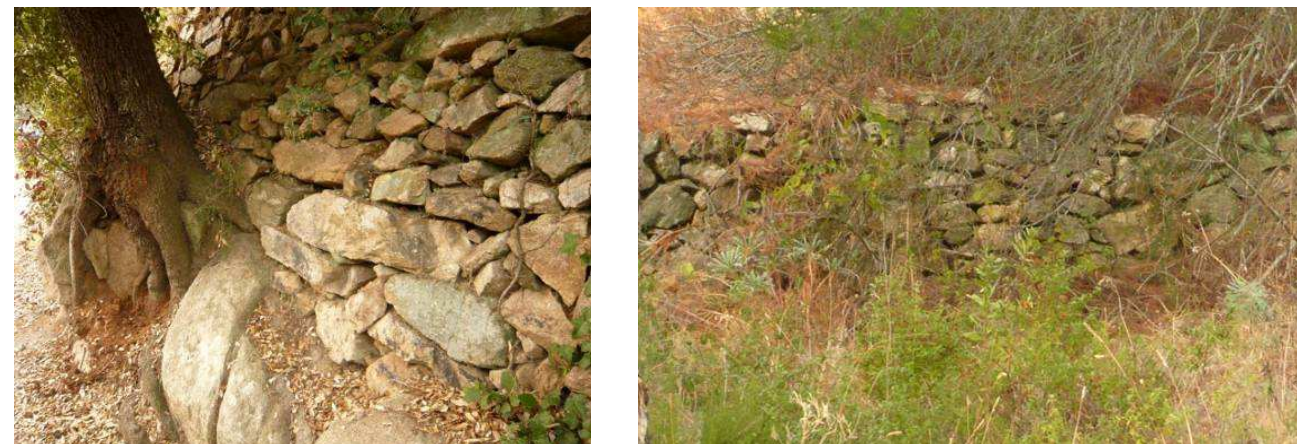
Murs en pierres sèches sur le site des Combes-Jauffret
