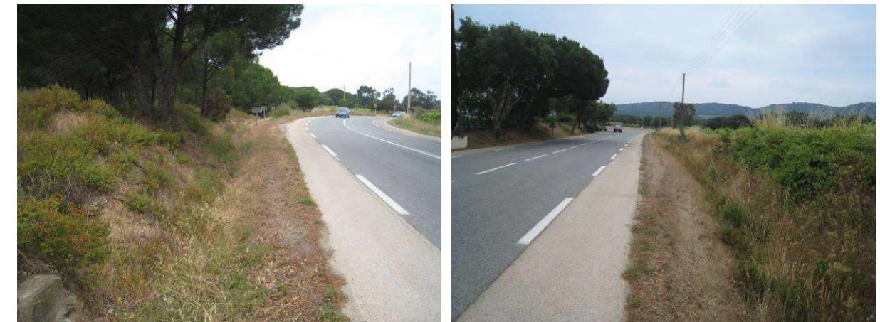
Fossé pluvial le long de la RD 93 (amont)
