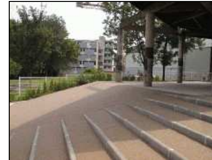
Revêtement de sol poreux
