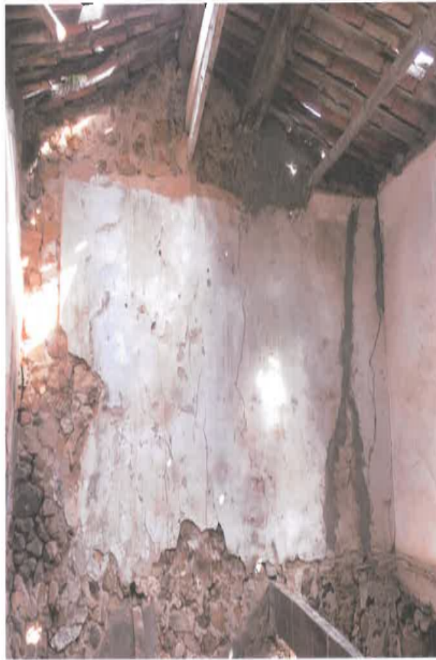
Face Intérieure du Pignon Est vue depuis l'Ouest (R+1)
