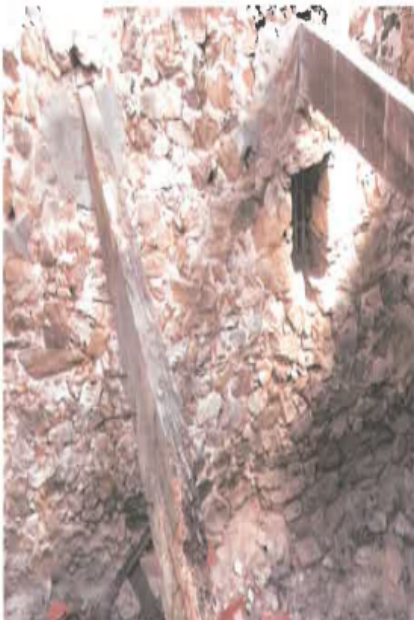
Détail poutre - Face Intérieure du Pignon Est
