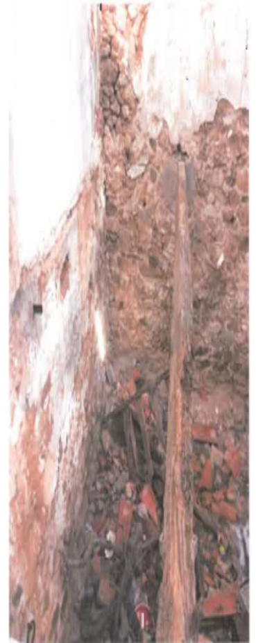
2 Angle Nord-Est (intérieur)
