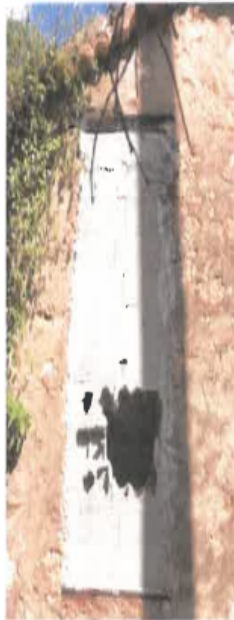
3 Ouverture murée - Façade Ouest (R+1)
