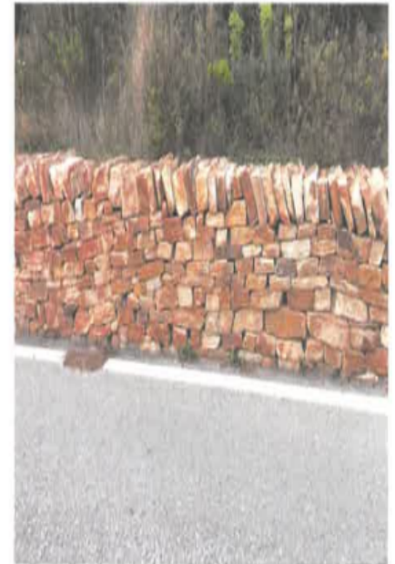
5 Muret en pierre sèche locale, Chemin des Combes
