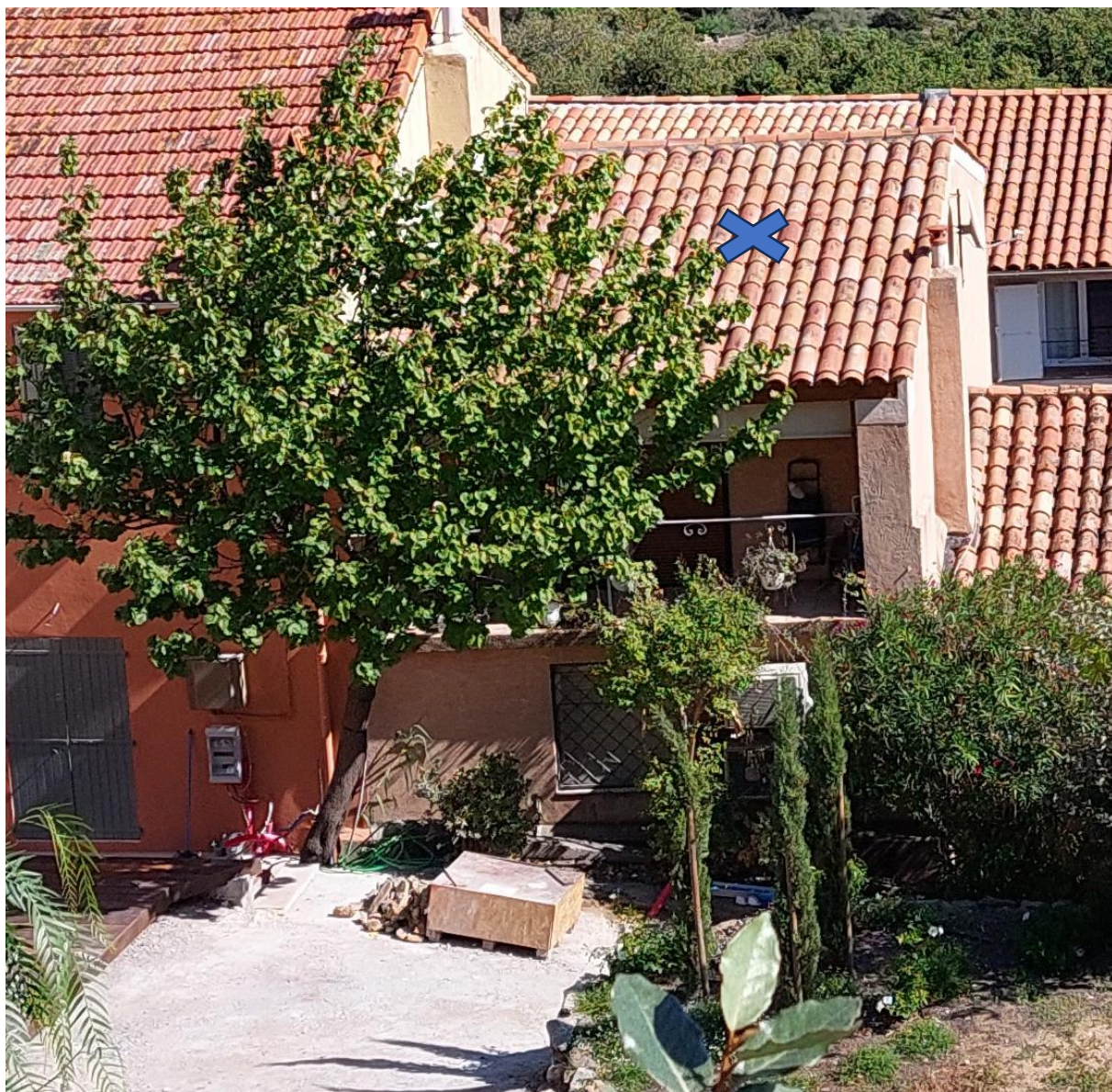
Photographie de la façade arrière
