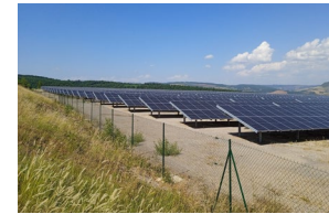
Centrale installée sur une friche : les vues plongeantes sur le site depuis la route voisine sont préservées par un merlon végétalisé préexistant (à gauche de la vue). © Wolfgang Borst
