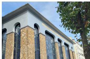
Encastrement en embrasure de baies, hôtel industriel Le Losserand, Paris – E. Saadi, architecte. © Roland Peltekian
