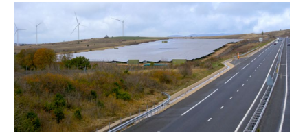
Parc photovoltaïque en bordure de l'A75, La Cavalerie (12). L'impact visuel d'une centrale est important aux abords immédiats de la voirie. Le choix de châssis légers améliore les perceptions à moyenne distance. © Étienne Louyriac
